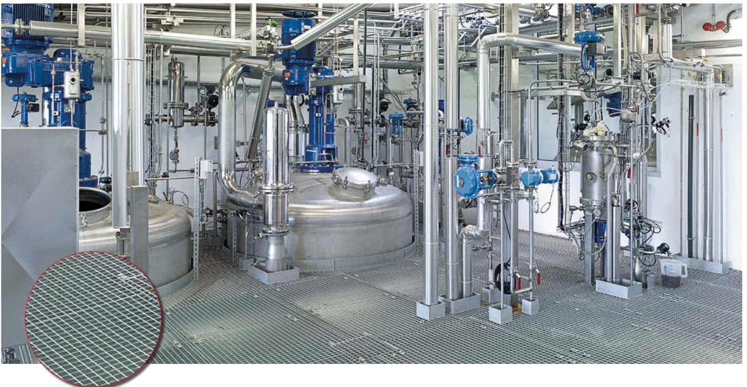
Die Sunliquid-Demonstrationsanlage der Clariant AG ist die deutschlandweit bisher größte Anlage zur Produktion von Bioethanol. Die mit der Produktion von Bioethanol einhergehenden Gefahren erfordern hohe Sicherheitsstandards, die MEISER Schweißpressroste zur Gänze erfüllen. Sowohl die schwere Entflammbarkeit als auch die Beständigkeit gegen Chemikalien sprechen für den Einsatz von MEISER Schweißpressrosten in der Bioethanolproduktion.
